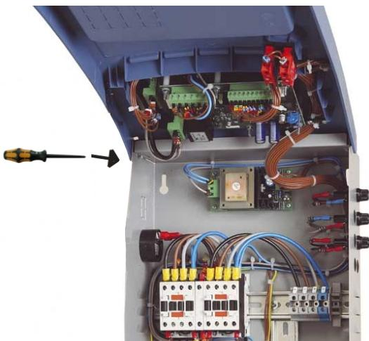
Чтобы передняя часть панели была открыта нужно вставить отвертку в предназначенное для этого отверстие.
